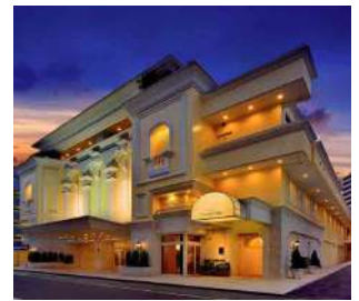
▲ ラ・ボア・ラクテ改修外装工事 【発注者】 ㈱西武百貨店 【使用部位】 モールディング・窓額縁・装飾柱・アーチ・パネル キーストーンデンティル・ペディメント・
