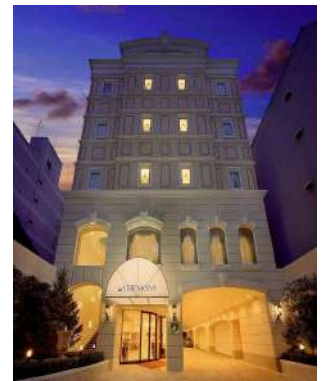
▲ セレモニー大宮ホール 外装工事 【発注者】 松井建設(株) 【使用部位】 モールディング・デンティル 窓額縁・キーストーン
