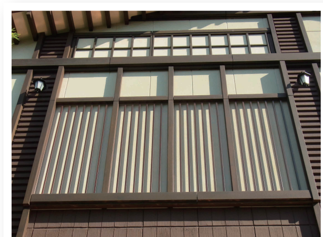
▲格子部分が木目塗装を施され、ALC 造の建物に使用された EPS 建材
